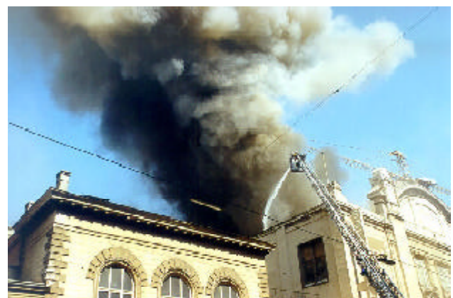
Das größte Brandschadensereignis 2001: alle Fotos unter www.firefighter.at
