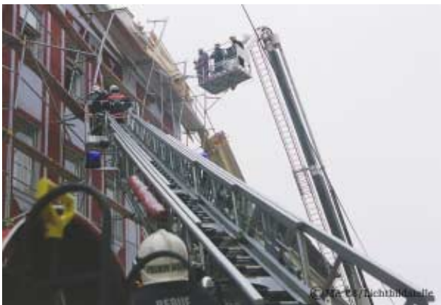
Gerüsteinsturz: Heilloses Durcheinander
